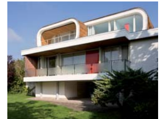
SURÉLÉVATION D'UNE MAISON SUR L'ÎLE DE VAUX SUR SEINE 54
