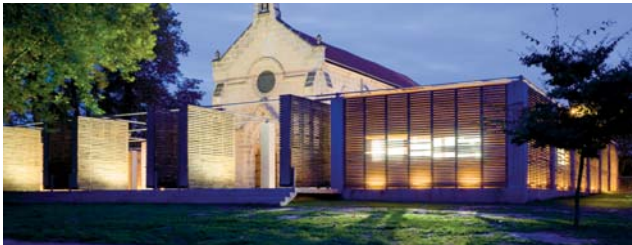
AMÉNAGEMENT DE LA CHAPELLE MUSSONVILLE EN SALLE DE SPECTACLE 42
