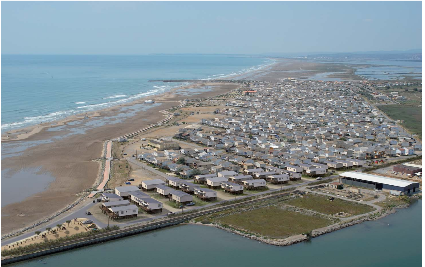
Plage des Chalets, rangée 11, est né ce projet qui comprend 21 chalets F4, 9 chalets F3, 3 chalets F2 et 1 chalet F1. Avec un permis de construire obtenu en 2008, le chantier a pris fin en 2011.
