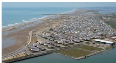
CONSTRUCTION D'UNE RANGÉE DE 34 CHALETS SUR PILOTIS 64
