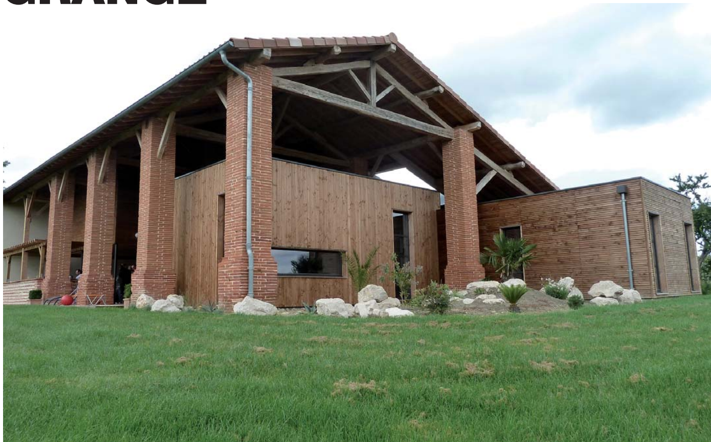
Le projet, réalisé en 2010 : transformer une grange en maison individuelle.
