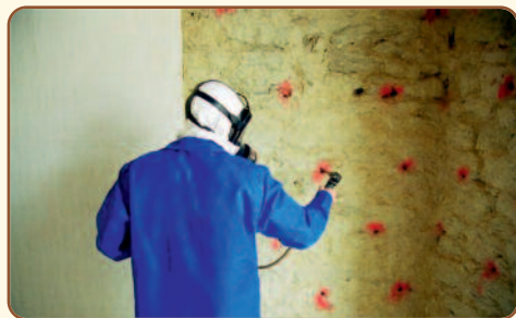
injection des maçonneries
