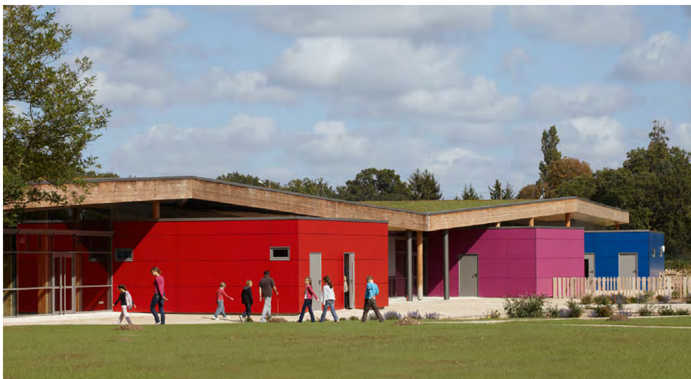
Vues des façades donnant sur le parc.
