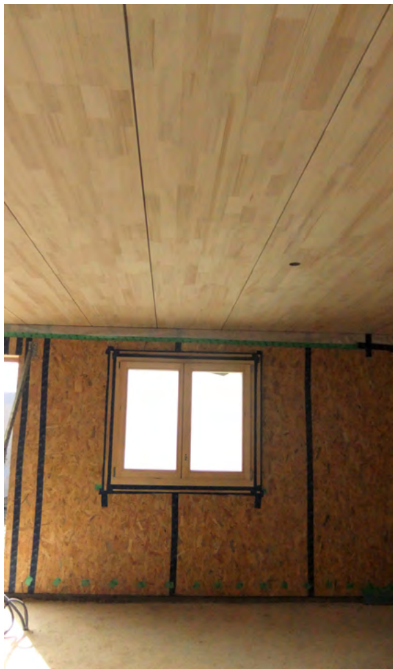
Sous-face des planchers caissons et parois.
