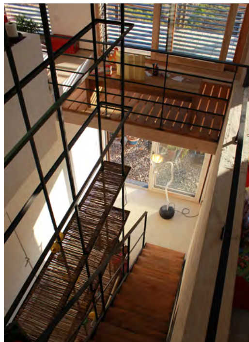
Mur béton et escalier bois acier.
