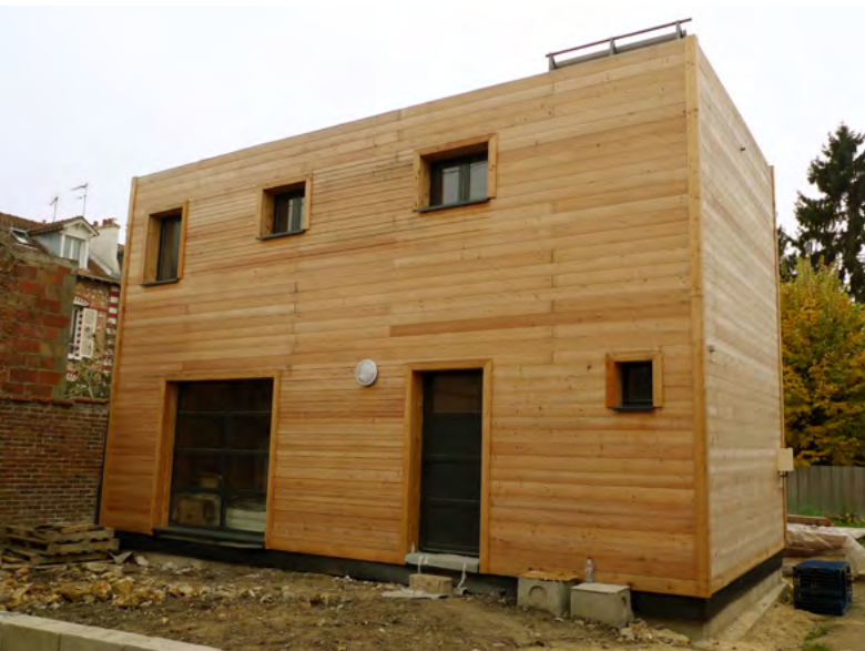
Vues des façades : bardage en douglas et larges baies vitrées au rez-de-chaussée.
