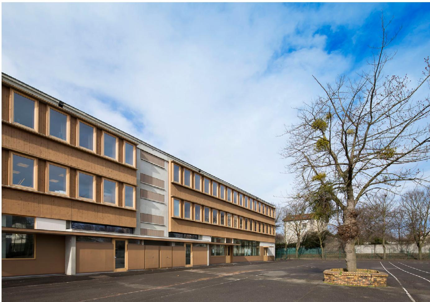
Le bâtiment existant a une volumétrie simple tramée structurellement en un système poteaux-poutres-planchers béton. Ses façades sont rythmées par des ensembles bois (allèges/meneaux en panneaux amiantés) pris entre les planchers et la trame verticale de poteaux et refends béton.
