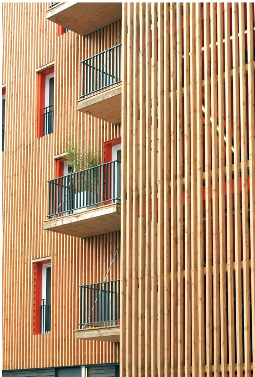
LE CONCOURS LANCÉ PAR FRANCE HABITATION À FOSSES, avait pour double objectif : la maîtrise des coûts – recherchée par le biais de la conception-construction – et l'optimisation des délais, au moyen de la préfabrication (principe constructif mixte béton/bois).
