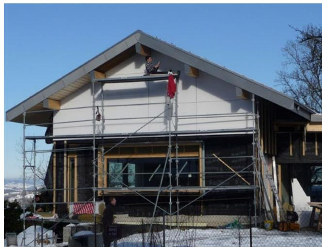
Pose du bardage Mineralis sur l'ossature bois.
